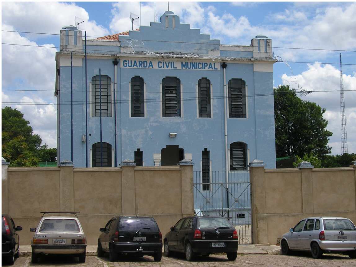
Anexo G: Figura 7 Imagem do Prédio da Guarda Civil
